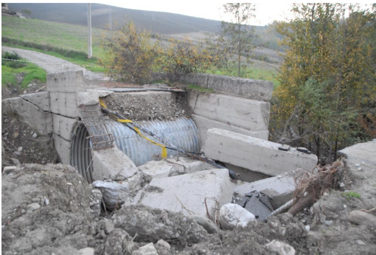
Figura 15. Ponte crollato lungo la strada interpodereale per Poggio Mondrone
